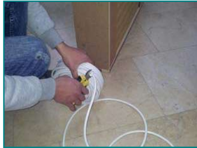
5. اختيار كابل (3X1.5) لتوصيل مصدر الجهد المتناوب إلى العلبة
