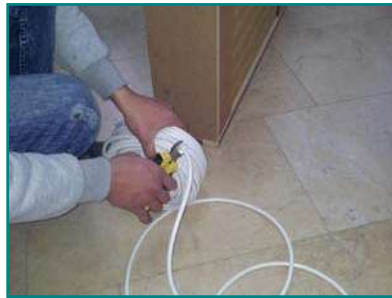
5. اختيار كابل (3X1.5) لتوصيل مصدر الجهد المتناوب إلى العلبة
