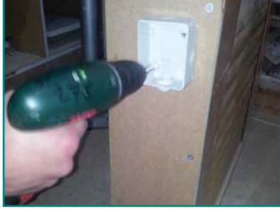
3. تحديد مكان تثبيت علبة تجميع الضاغط المزدوج وتركيبها
