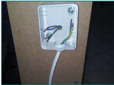
9. إدخال طرف كابل توصيل المحرك من المكان المخصص لذلك إلى علبة التجميع الخاصة بالضاغط المزدوج
