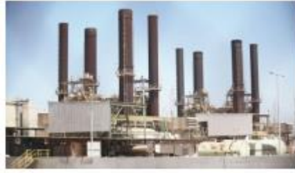
محطة توليد الكهرباء في غزة
