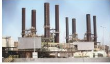
محطة توليد الكهرباء في غزة
