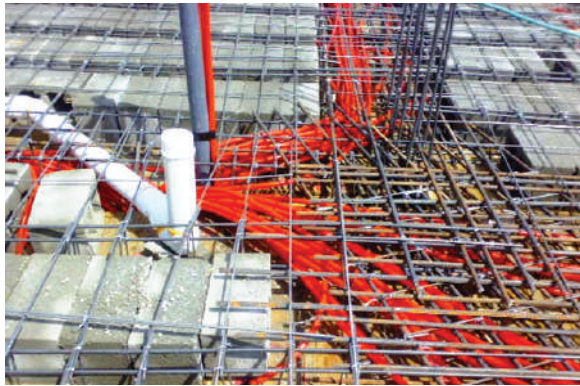
شكل (10): تمديد كابلات الاتصالات عبر أنابيب بلاستيكية
