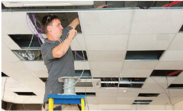
شكل (8): تمديد الأسلاك عبر السقف المعلق
