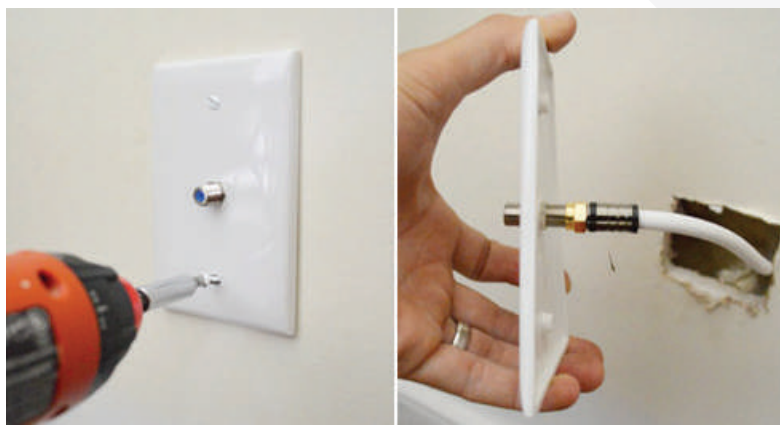
شكل (15): توصيل مقبس الإشارة بالهوائي الصحنى (من اللاقط أو الدايسك) باستخدام الكابل المحوري
