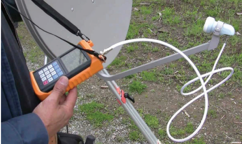
شكل (12): معايرة الهوائي الصخني واللاقط باستخدام جهاز ضبط الإشارة
