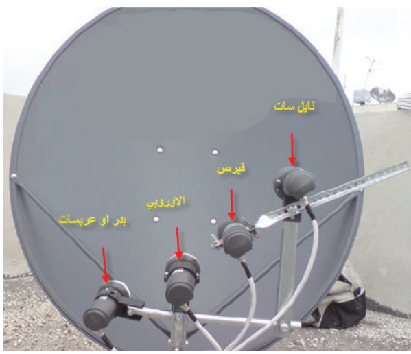
شكل (13): توصيل اللاقط/ اللواقط باستخدام الكابل المحوري
